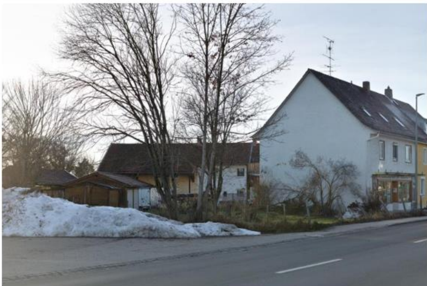
Hier soll ein Stellplatz für Wechselbrücken-Container entstehen. Anwohner sind von der Idee alles andere als begeistert.
